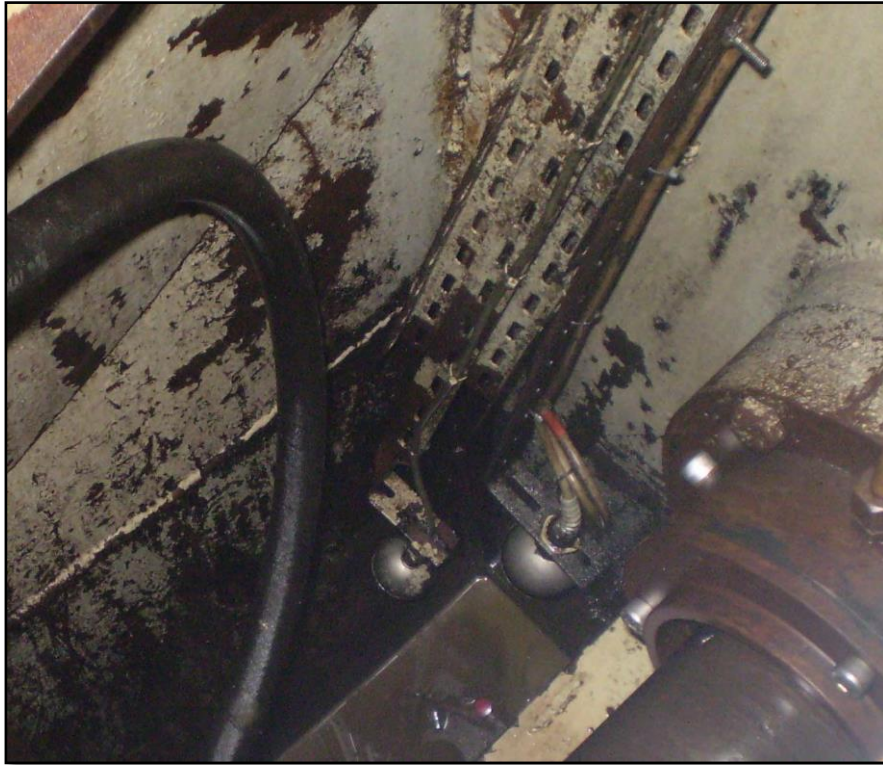
Annexe C2 : flotteurs alarme niveau d'eau machine
