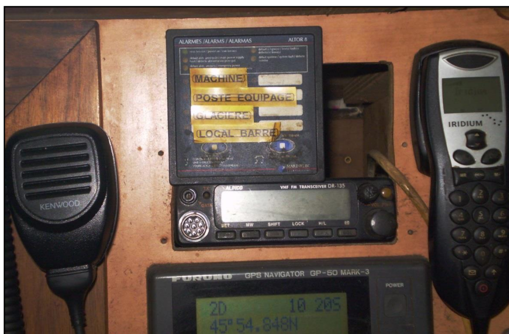
Annexe C1 : Renvoi d'alarmes de montée d'eau en passerelle
