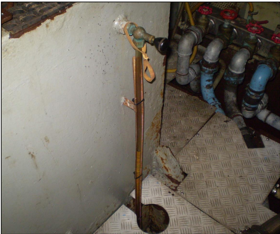
Annexe C5 : monture de niveau sur caisse gasoil
