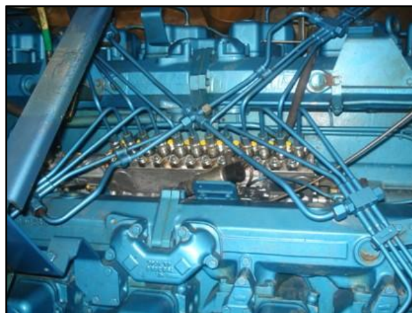
Moteur Beaudoin 12M26SR : Nappe de tubes d'injection et pompe.
