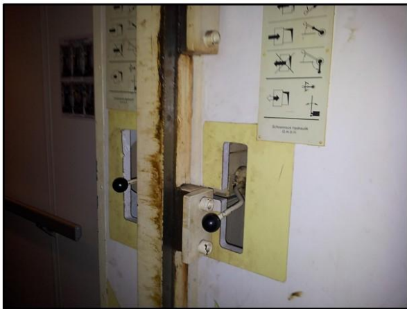
Manettes de manœuvre (locales) de la PE
