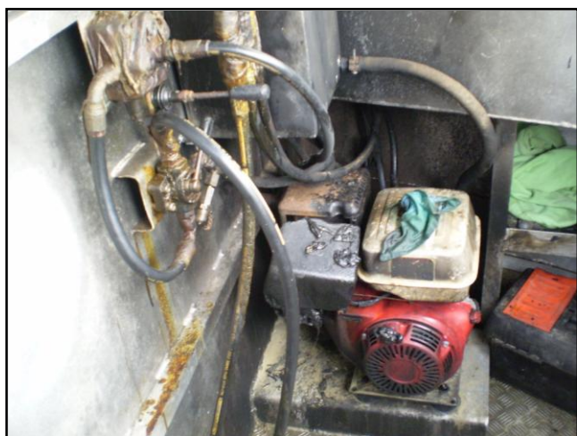
Disposition du groupe dans la timonerie. Photo prise après l'incendie.
