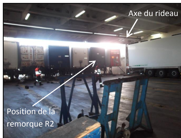
Vue de la partie arrière bâbord du pont 5. On aperçoit le rideau isolant type portefeuille positionné en plafond.
