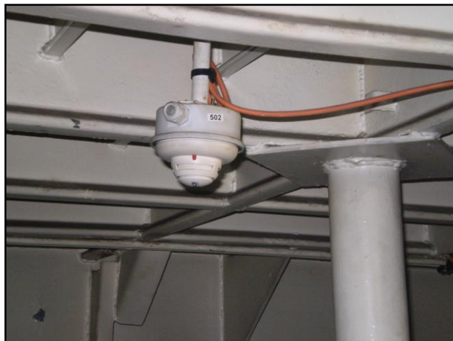
Détecteur incendie du local Aquamaster
