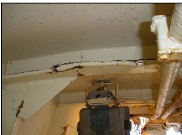
Au niveau des œuvres mortes tribord, la cloison transversale du local batteries et celle en avant des treuils sont à reprendre, ainsi que des fissures au niveau des croisements des goussets au local des batteries jusqu'en arrière des treuils au-dessus du pont principal.
