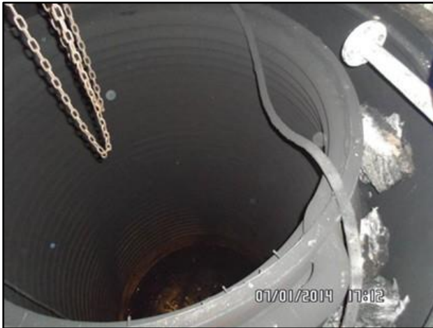
Le foyer, après démontage de la partie supérieure de la chaudière (crédit Sea Tankers).
