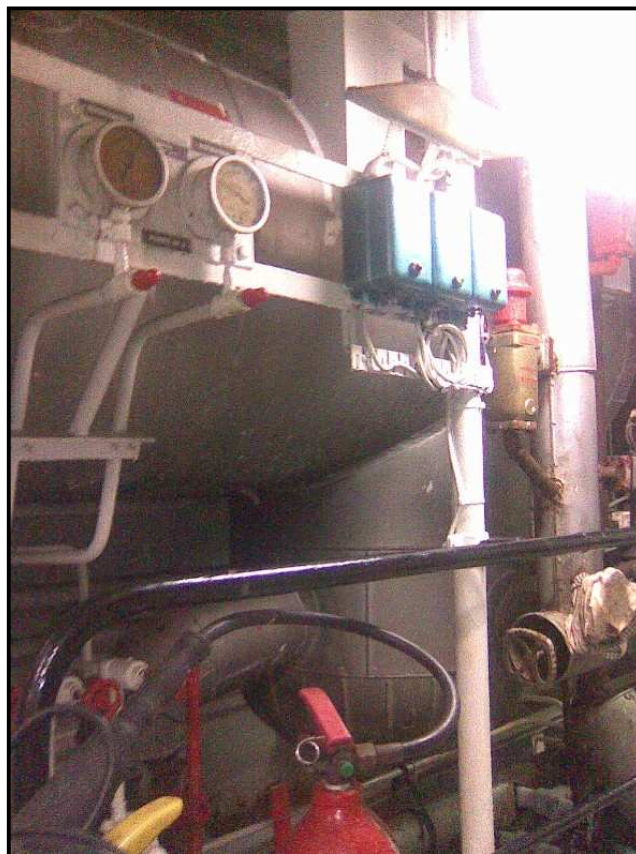
Local des compresseurs - Réservoir flood n°2 (Vue partielle)
