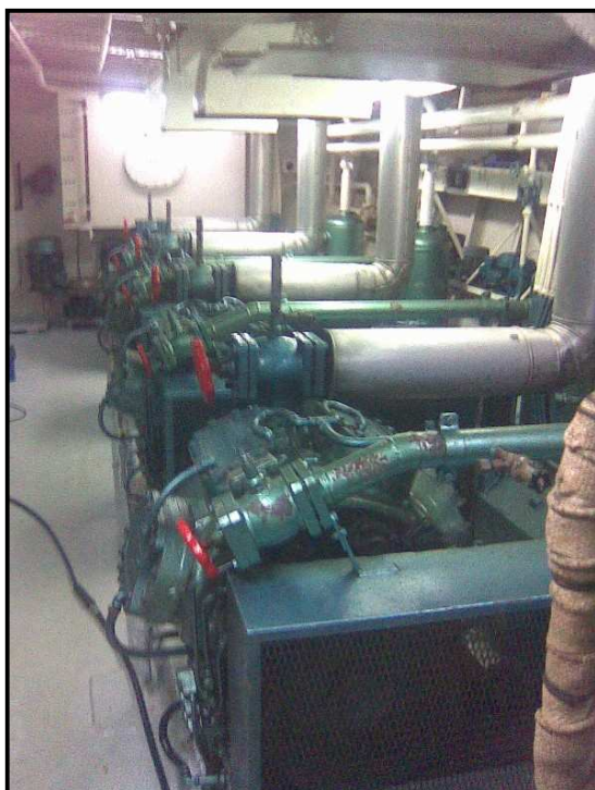
Local des compresseurs – Vue générale
