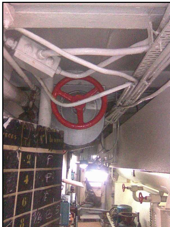
Local des compresseurs Vanne n°15 manœuvrée par erreur sur collecteur de retour aspiration des cuves flood n°2
