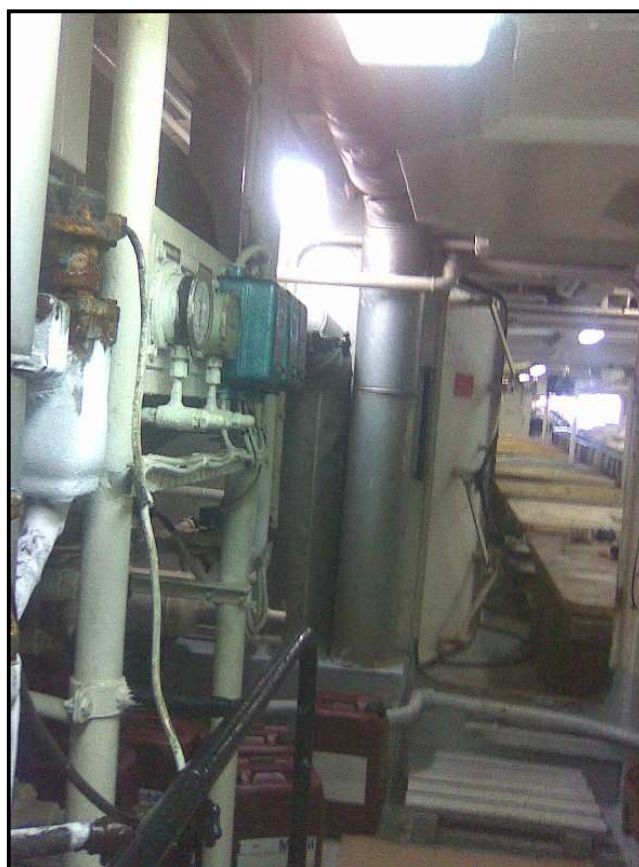
Local des compresseurs Porte étanche de communication avec l'entrepont
