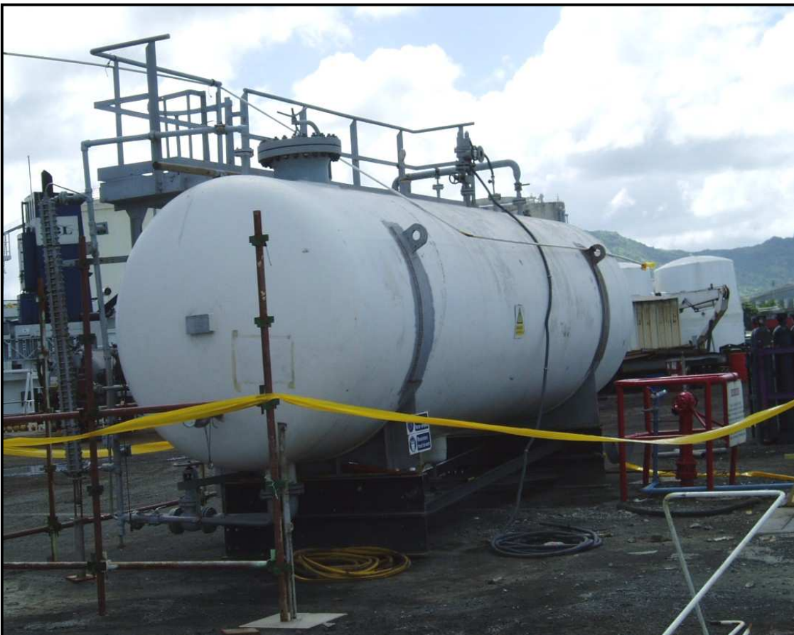
Chantier Naval de l'Océan Indien (CNOI) - Ile Maurice Cuve de réception de l'ammoniac
