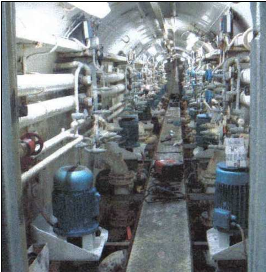
Tunnel, vue d'ensemble
