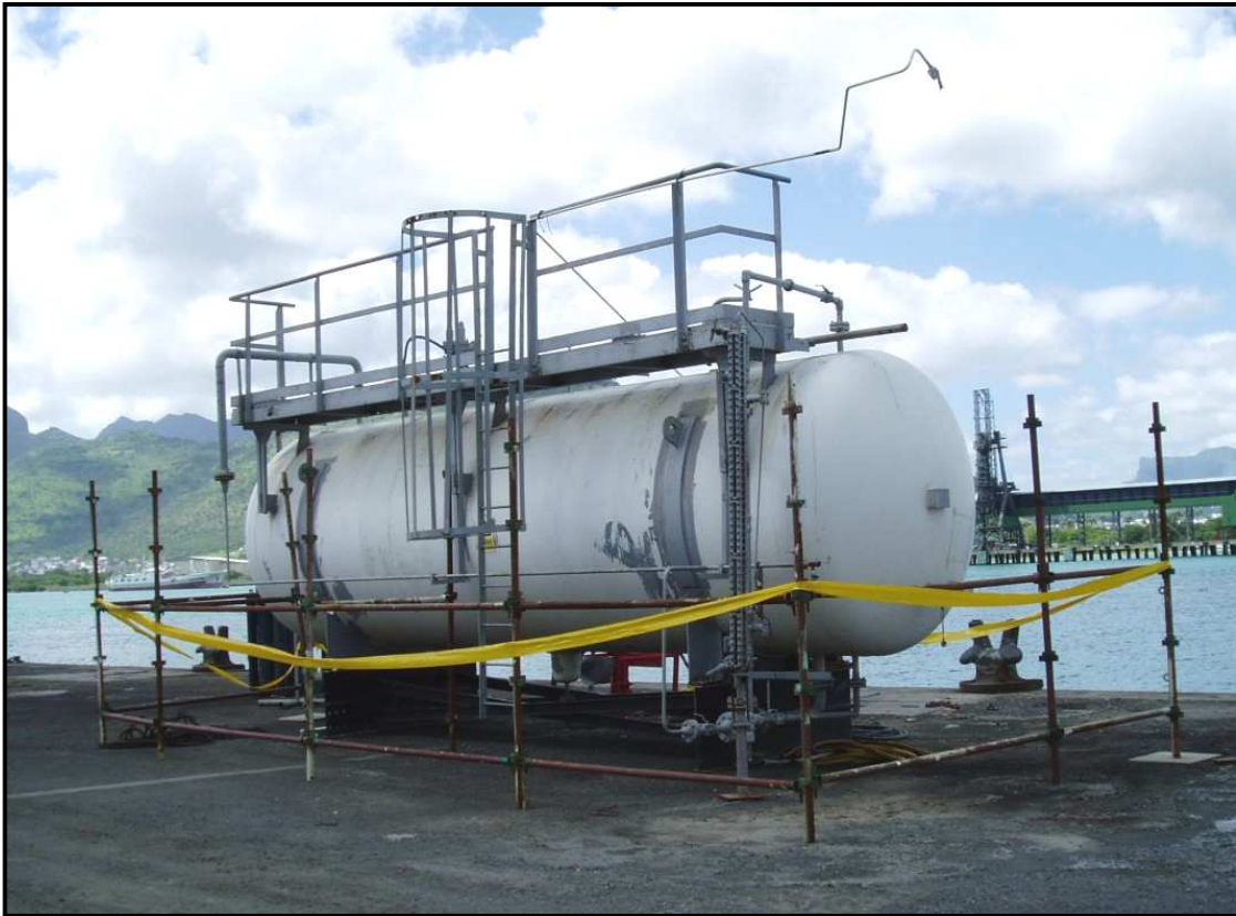
Chantier Naval de l'Océan Indien (CNOI) - Ile Maurice Cuve de réception de l'ammoniac
