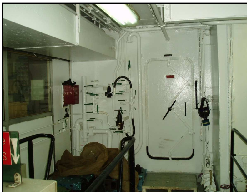
Porte étanche de communication compartiment machine / local des compresseurs - Vue du compartiment machine
