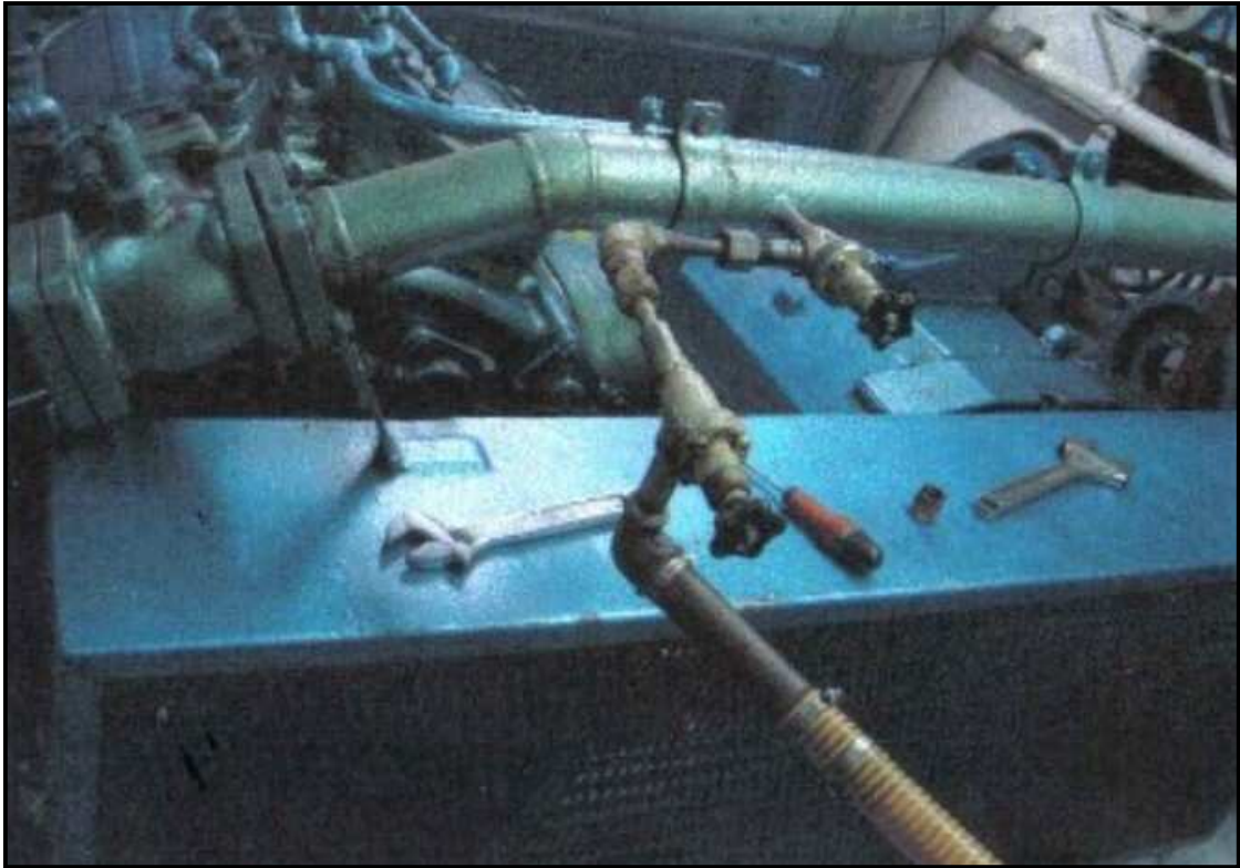
Dispositif de purge sur le tuyau de refoulement du compresseur
