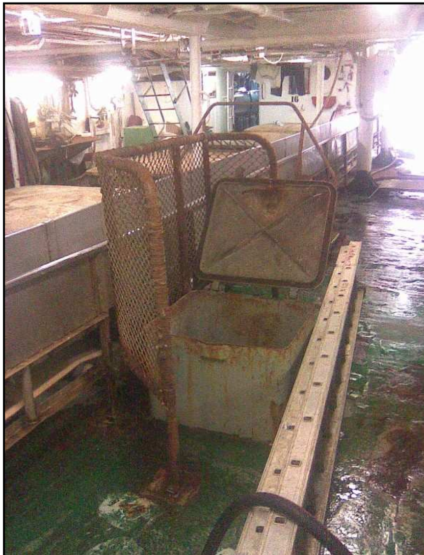
Sortie de l'échappée tunnel dans l'entrepont
