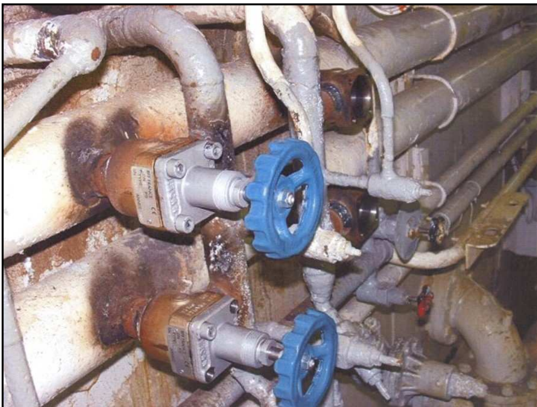
Tunnel - Collecteurs aspiration des cuves à poisson Vannes en cours de montage
