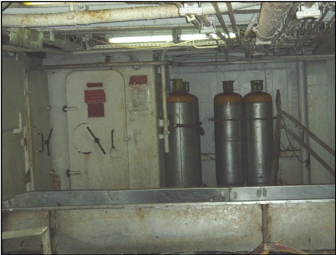
Stockage des bouteilles d'ammoniac dans l'entrepont
