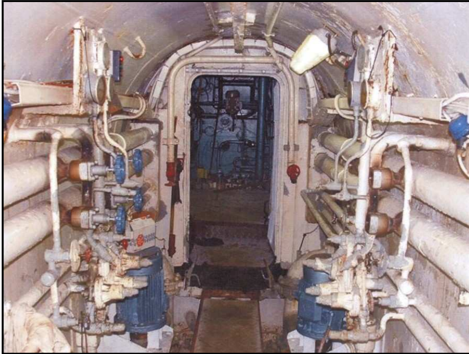
Porte étanche de communication entre tunnel et compartiment machine
