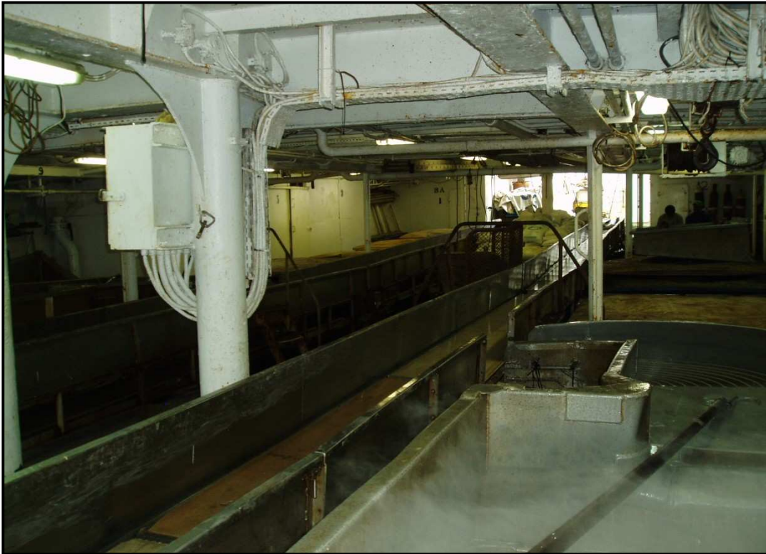
Entrepont - Vue intérieure
