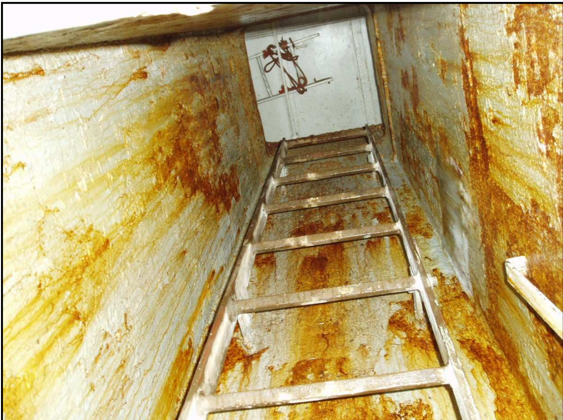
Vue intérieure de l'échappée du tunnel
