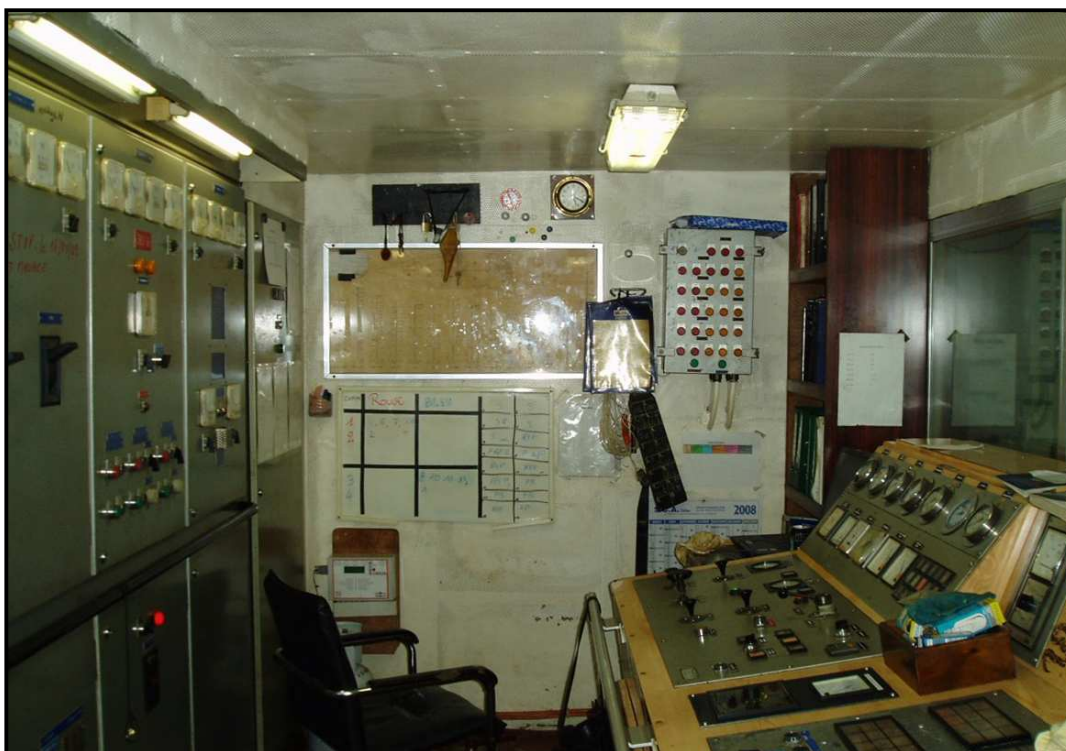
Salle de contrôle machine. On aperçoit au fond le coffret des alarmes de l'installation frigorifique
