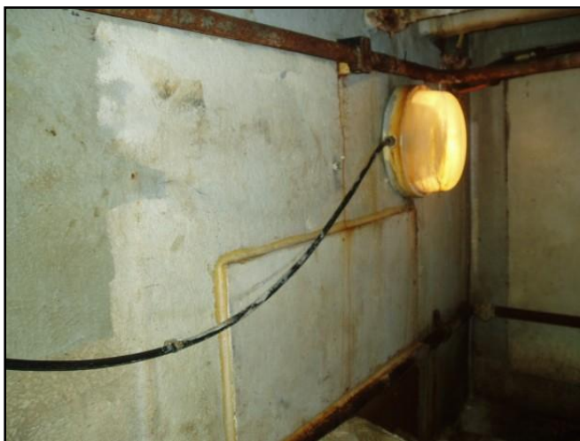
Réparation de la cloison AR du compartiment machine.
