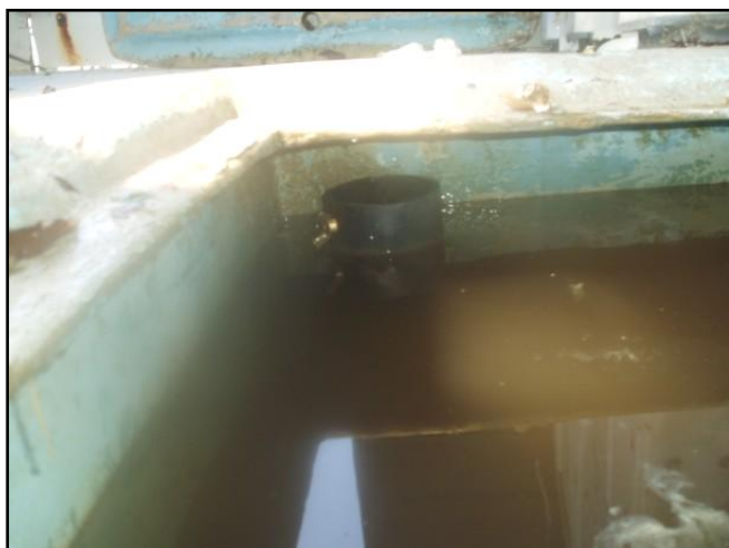
Vivier : dispositif d'évacuation du trop-plein.
