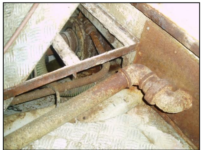
Tuyauterie de vidange du vivier passant à travers la partie basse de la cloison AR machine
