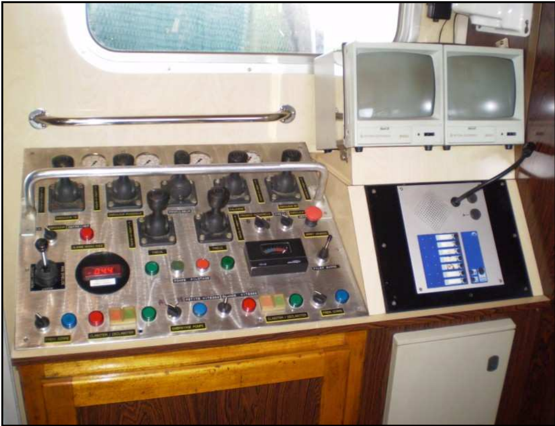
Poste de commande des treuils
