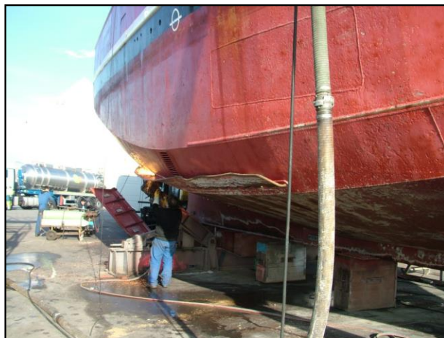
Quille antiroulis en cours de découpage
