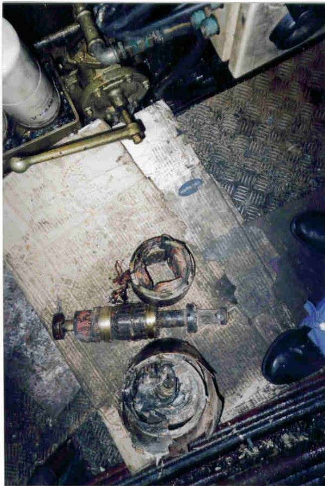
Ventilateur machine-moteur électrique.
