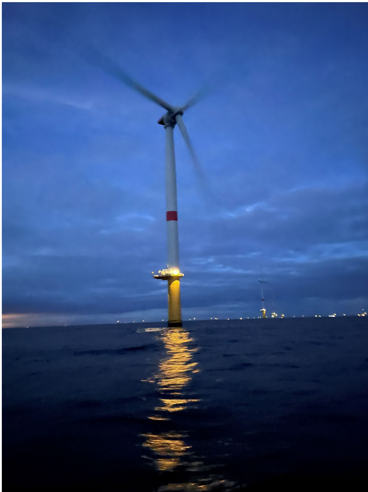
Figure 3: Vue de l'éolienne D05, située à l'intérieur du parc, non munie de feux de signalisation distinctifs. Source : BEA mer, cliché pris le 26 juin 2026 à 23h06.
