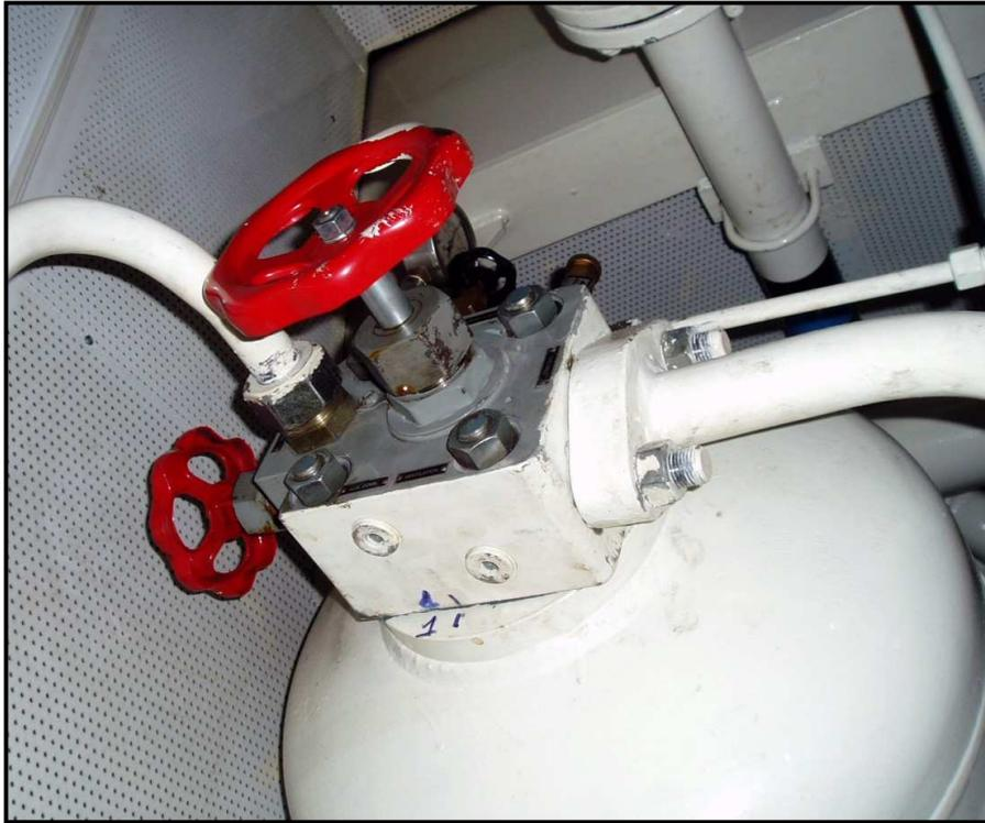
SD GIRONDE – Bouteille d'air supérieure – Soupape de tête.
