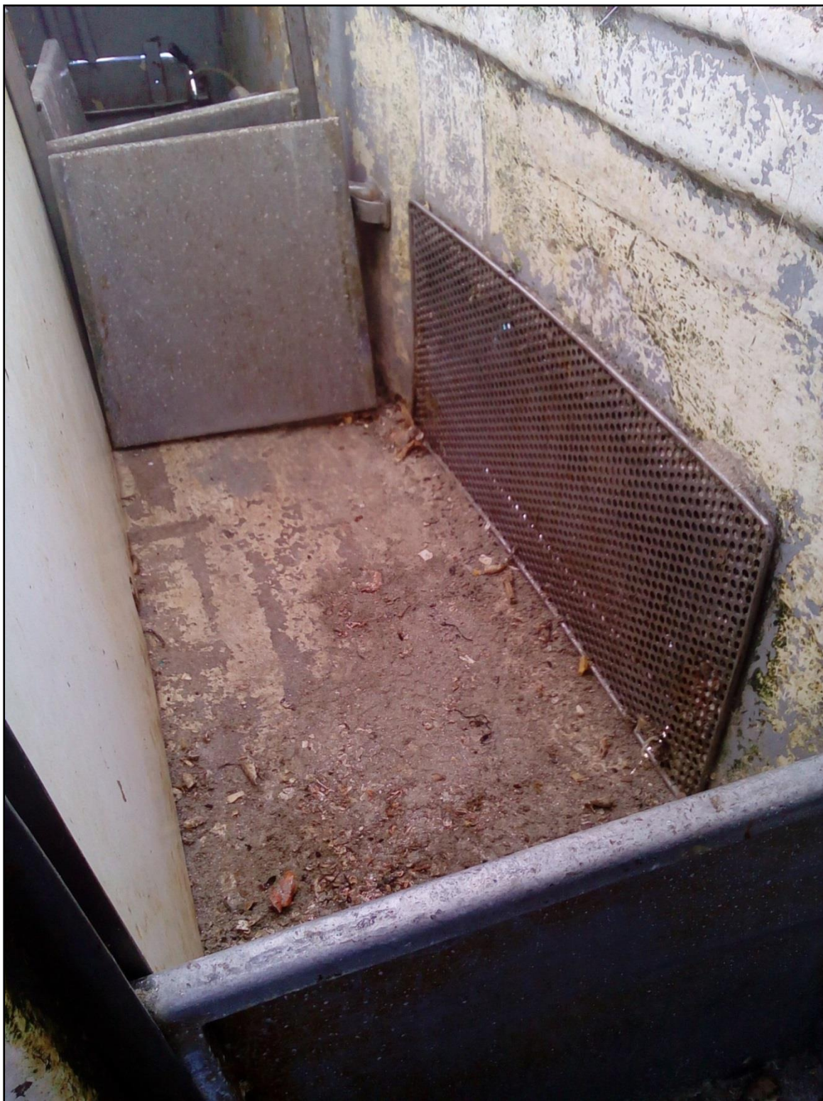
8 - Sabord situé sur le pavois bâbord vers l'arrière fermé par une grille
