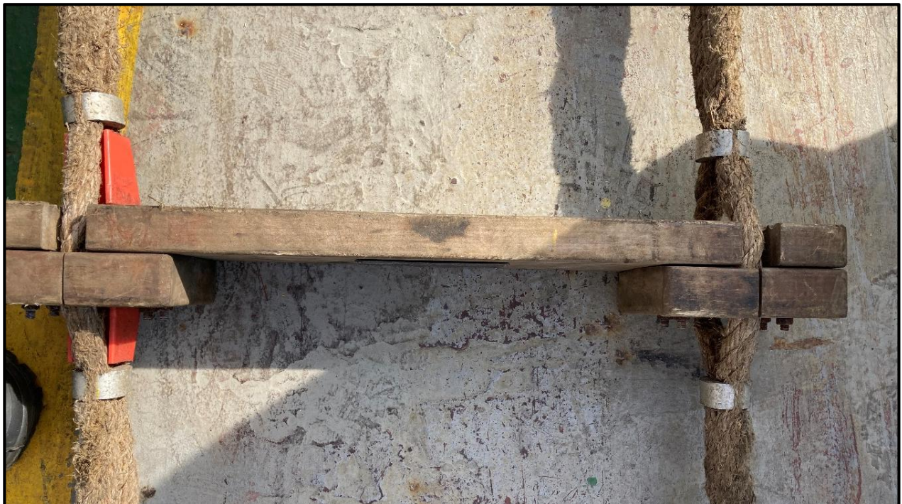
Marche d'échelle remplacée et entretoise manquante.
