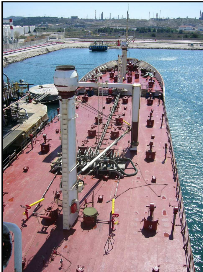
Vue du pont depuis la passerelle
