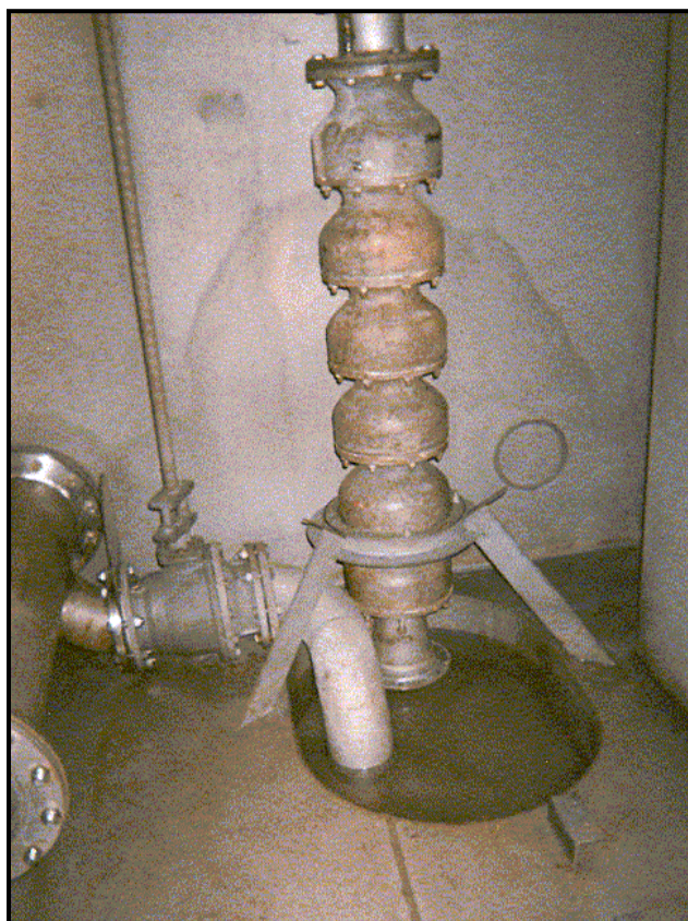
Installation de la pompe dans la citerne n° 12.
