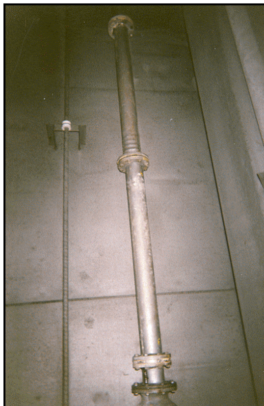
Citerne n° 12. Tube de refoulement de la pompe.
